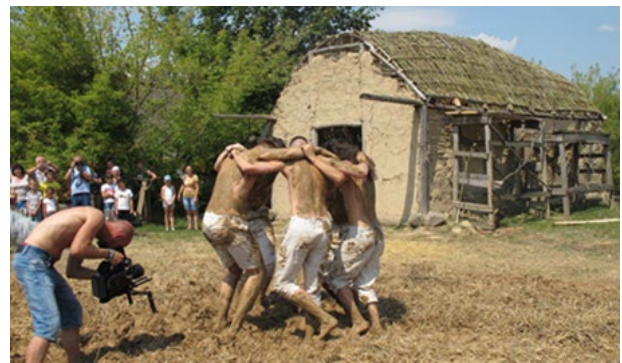
Рис. 7. Сучасна реконструкція технології глинобиття.
