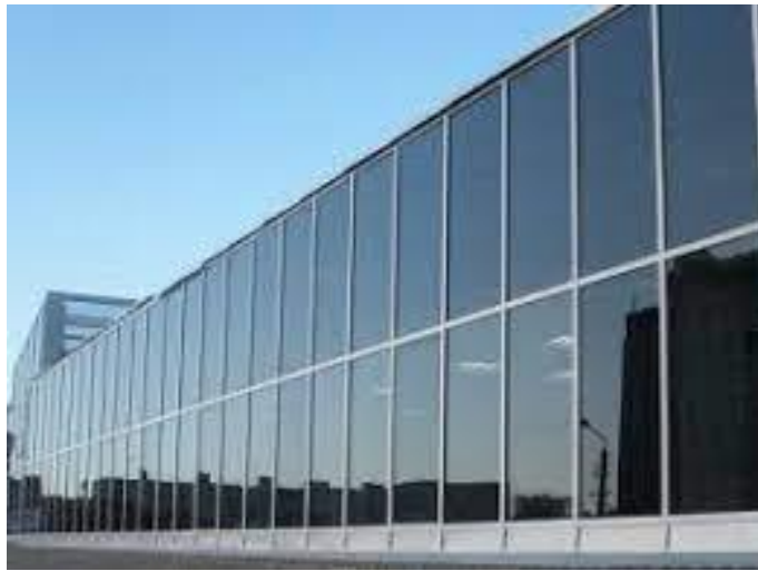
Рис. 3. Приклад стрічкового скління фасаду промислової споруди
