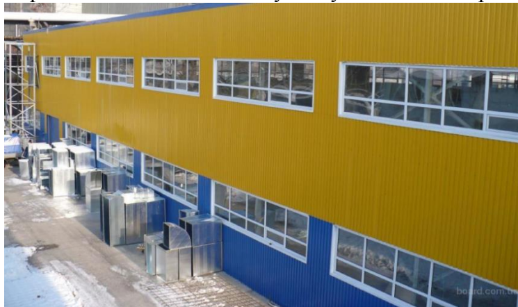
Рис. 2. Приклад ригельно-стійкової системи скління фасаду промислової споруди
