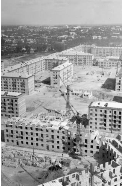
Рис. 1. Загальний вид будівництва масиву на Чоколовці, Київ (1958 р.)
