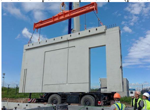
Рис. 6. Перенесення блоку будинку Well-being ConTech на будівельний майданчик [6]
