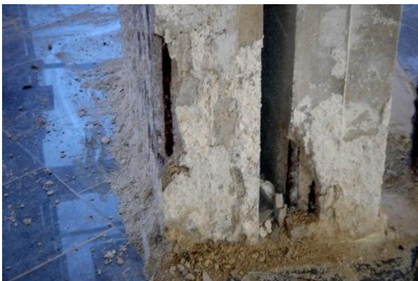
Рис. 1. Приклади типів пошкодження стиснутих елементів
