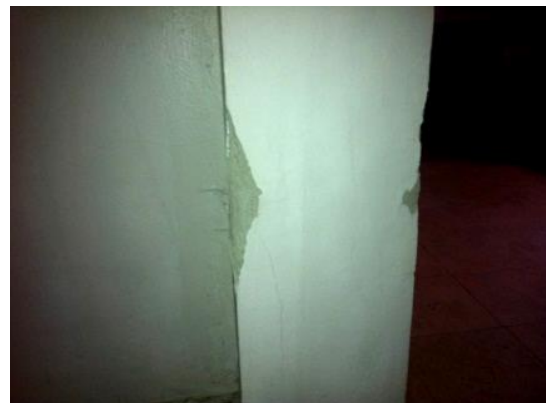
Рис. 1. Приклади типів пошкодження стиснутих елементів
