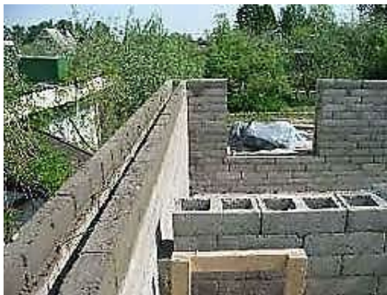
Рисунок 1.4 – Стіни виготовлені з пустотних і суцільних блоків
