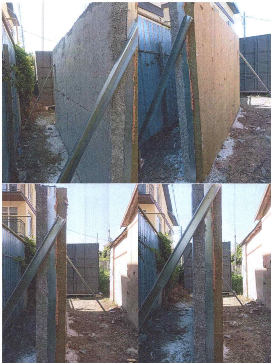
Рисунок 1 – Зразок зовнішньої стіни з мінеральної вати із заповненням пінополістиролбетоном зі змінною опалубкою з ламінованої фанери з обох боків та встановленням ЛСТК всередину опалубного блоку
