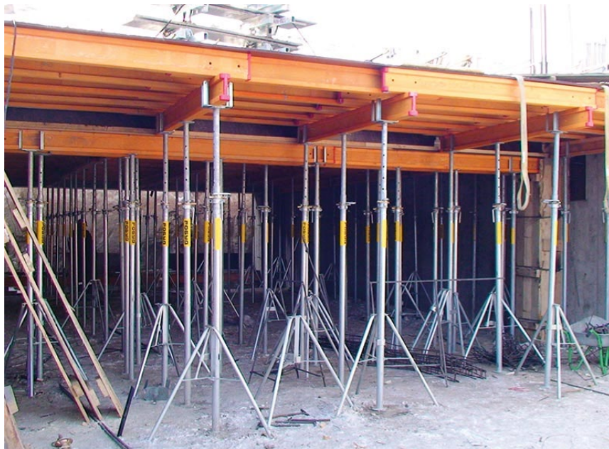
Рисунок А.10 – Встановлена опалубка перекриттів
