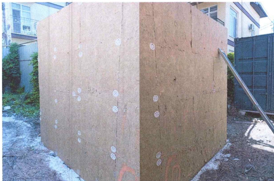
Рисунок 4 – Вид зовнішньої поверхні стіни з мінеральної вати із заповненням пінополістиролбетоном зі знімною опалубкою з ламінованої фанери з обох боків:
