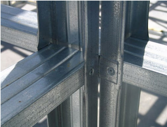
Рисунок А.9 – Приклад з'єднання профілів
