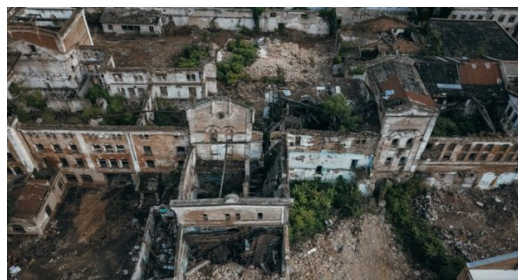
Рис 3. Завод Санценбахера після пожежі
