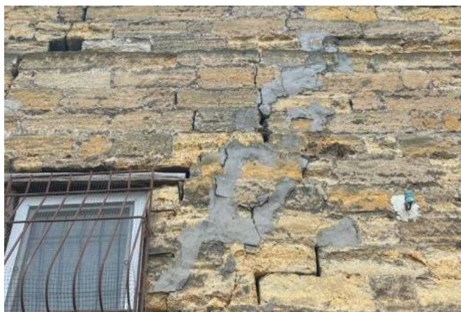
Рис. 1. Пошкодження та руйнація конструкцій будівель з вапняку-черепашника.
