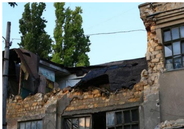
Рис. 1. Пошкодження та руйнація конструкцій будівель з вапняку-черепашника.
