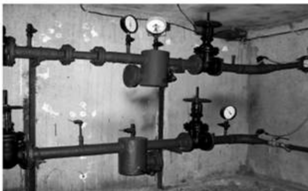
Рис. 1. - Общий вид абонентского ввода: до модернизации
