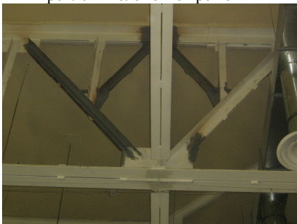
Рис. 2. Дополнительные элементы решетки
