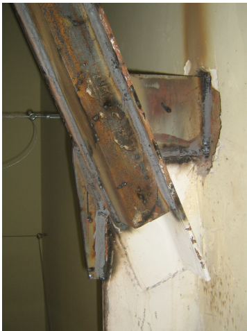
Рис 4. Увеличение сечения стержня опорного раскоса фермы
