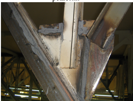
Рис. 3. Узел крепления дополнительных элементов решетки
