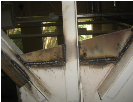
Рис. 1. Нарращивание длин сварных швов крепления элементов решетки
