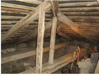
Рис. 4. Диагональная стропильная нога покрытия
