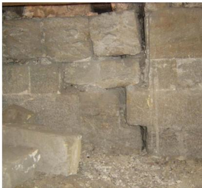
Рис. 3. Осадочные трещины в наружных стенах здания
