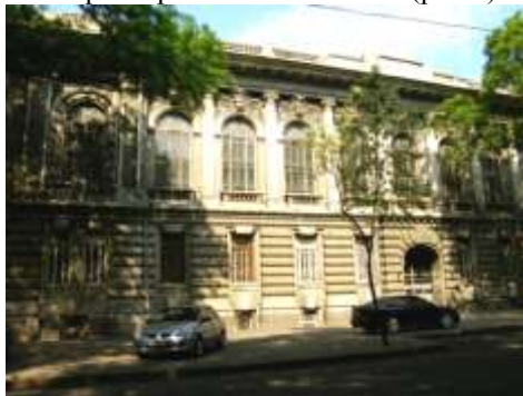
Рис. 1. Фотофиксация фасада здания по ул. Пастера 25.
