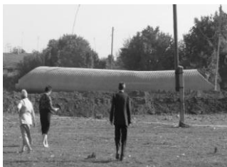
Фото 7. Унесенная потоком гофрированная труба
