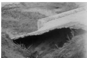
Фото 12. Разрушения искусственных сооружений вследствие отсутствия эксплуатационного содержания
