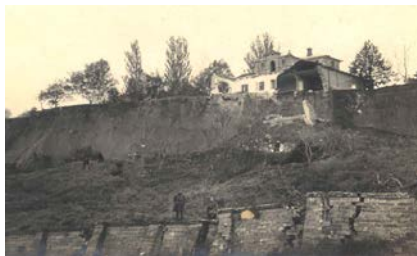
Рис. 1 Оползень на Ланжероне в г. Одессе (1918 г.)
