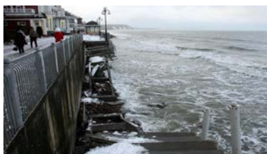
Рис.3,4 Шторм на Балтике в Светлогорске Калининградской области 13-15 января 2012 г., разрушение набережной
