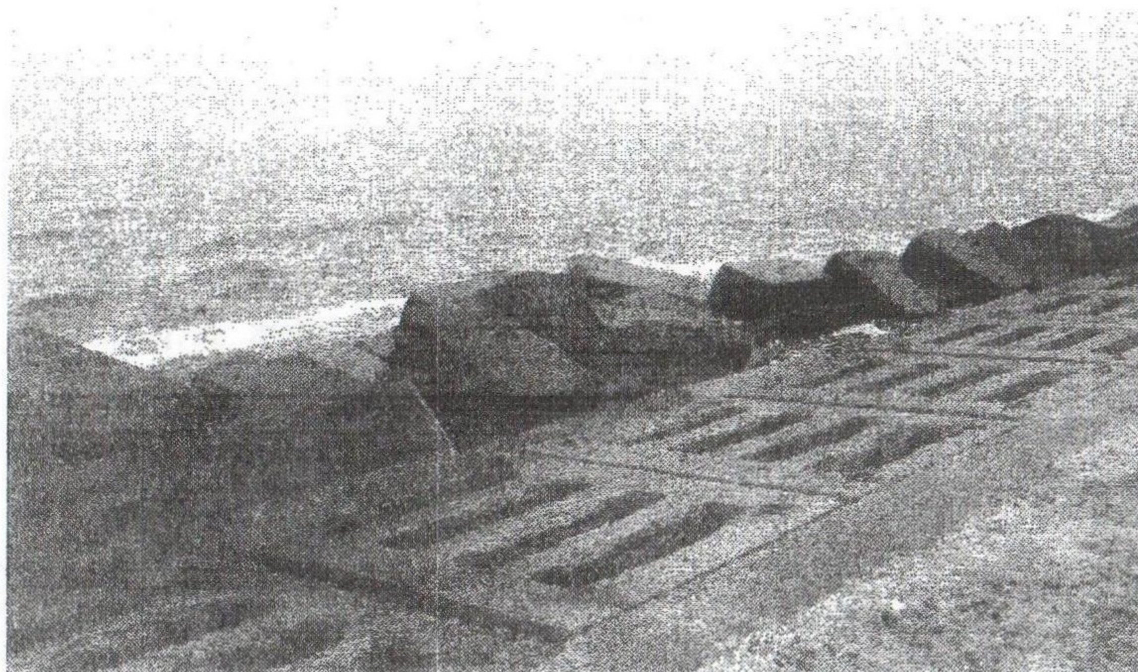
Рис.2. Укрепление склона со стороны моря
