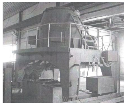
Рис.4. Виброгазобетономешалка по приготовлению растворной смеси
