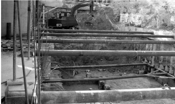
Фото 1. Второй этап строительства подземной части
