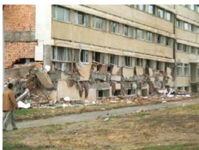
Фото 1-4. Характер разрушения каркасных зданий от сейсмического воздействия
