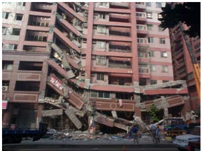
Фото 1-4. Характер разрушения каркасных зданий от сейсмического воздействия
