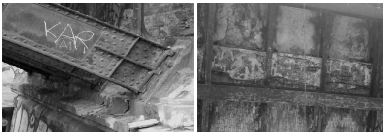
Рис.3. Мост Коцебу. Коррозия арок, разрушение плиты проезжей части.
