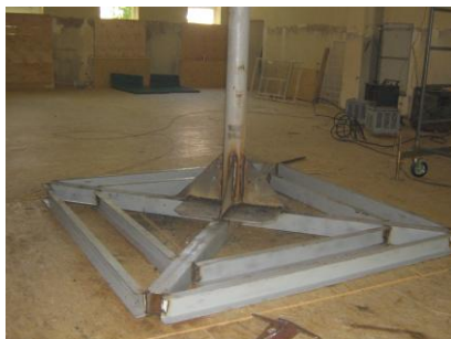
Рис. 6. База аварийной стойки
