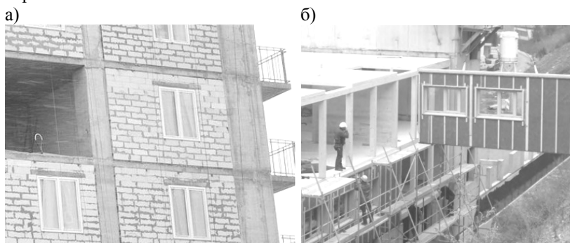
Рис. 1. Варианты наружных ограждающих конструкций многоэтажного каркасного здания
