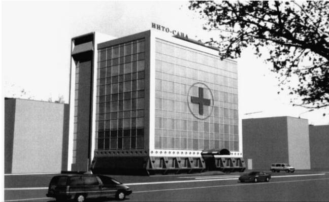
**Рис.6.** Проект реконструкции 5-ти этаж. жилого дома в г. Одессе под Медицинский центр Инто-Сана с устройством вентилируемого фасада и облицовки его стеклопакетами
