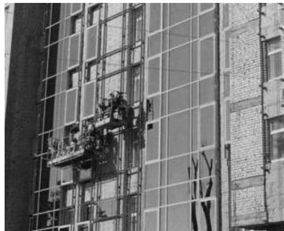
**Рис.7.** Реконструируемое здание в процессе утепления и облицовки фасадов
