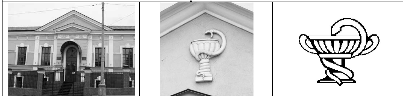
Рис. 5в. Здание городской бактериологической лаборатории, ул. Пастера, 3, бывшее народное училище Когана. 1892 г. Арх. С. А. Ландесман
