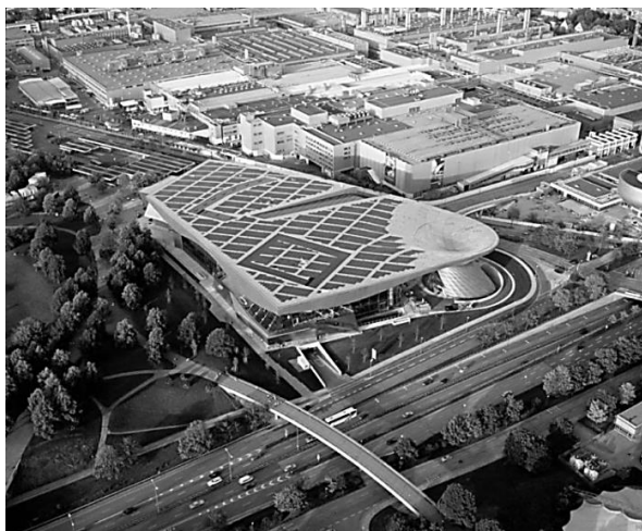
Рис. 1. Центр BMW в Мюнхене – солнечные батареи вмонтированы в кровлю.
