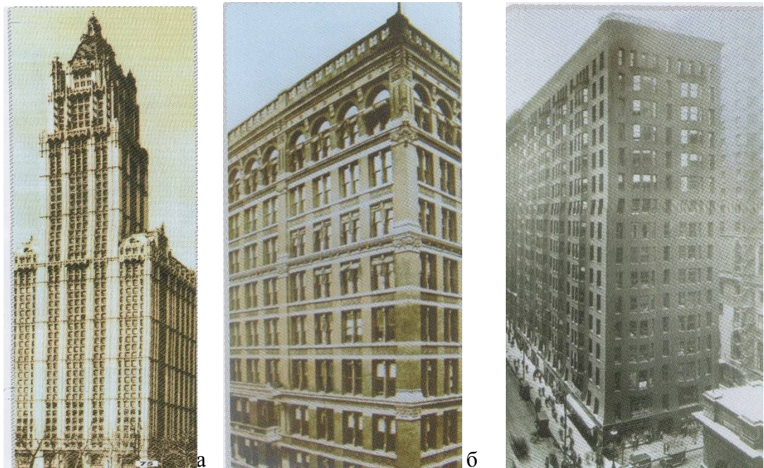
Рис. 1. а) небоскреб Вулворт, Нью-Йорк, 1913 г.; б) здание страховой компании, Чикаго, 1885 г.; в) 16-этажное здание, Чикаго, 1891 г.
