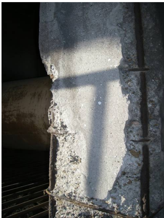
Рис 1.2. Разрушения сжатых железобетонных элементов, г. Одесса.
