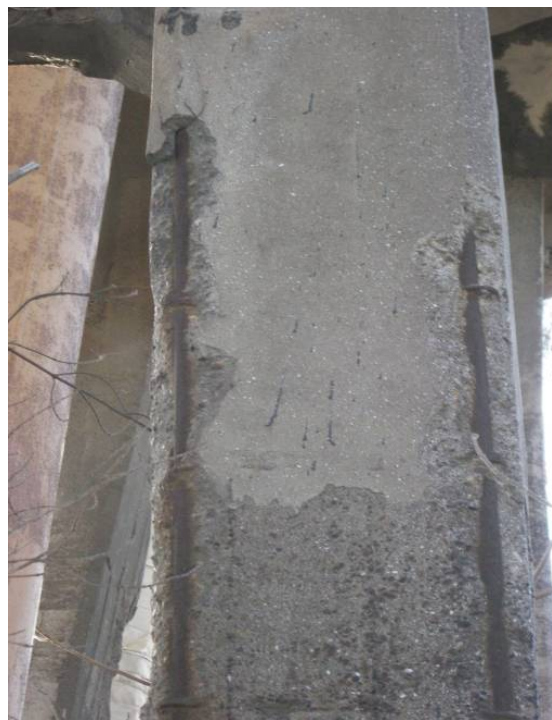
Рис 1.2. Разрушения сжатых железобетонных элементов, г. Одесса.
