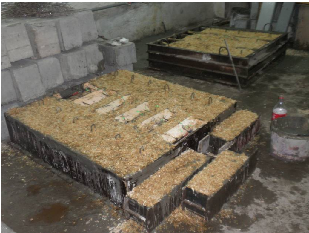
Рис.2.9. Уход за бетоном.
