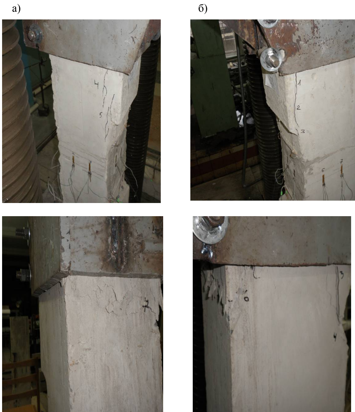
Рис. 3.11. Отслаивание пластинок бетона на образцах: а – 0 0-1; б – 1-1-1.
