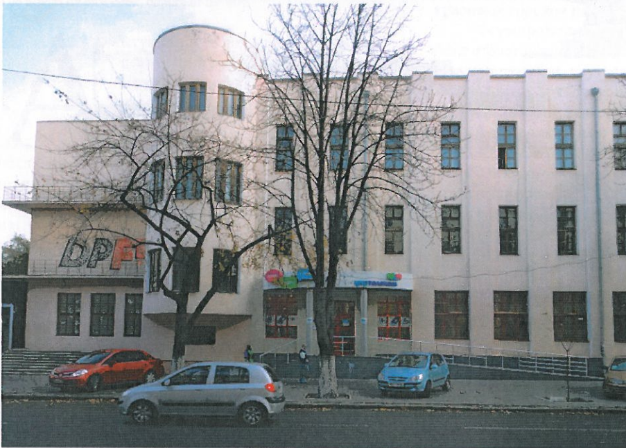
Рис. 5. Здание городской телефонной станции по ул. Екатерининской, 37 (арх. Н. Гуревич, 1929-1931 гг.). Современное состояние. Фото С. Смоленской
