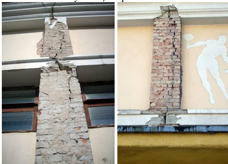
Рис. 1.4. Зріз по перев'язаному перерізу несучих простінків спортивного манежу
