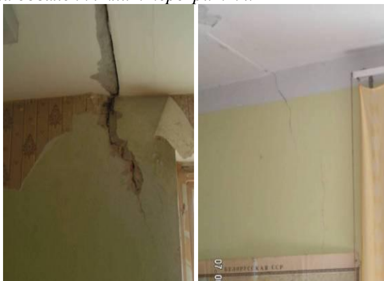
Рис. 1.3. Зріз кладки несучих простінків під опорами перемичок
