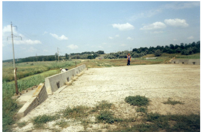
Рисунок 4 – Мост через речку Ташбунар на автомобильной дороге «Подъезд к г. Измаил»
