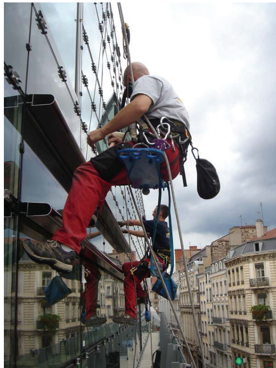
Рисунок 4. Пример монтажа фасадной солнечной батареи.
