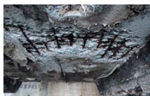
Характер разрушения элементов конструкции эстакад
