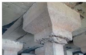
Рис. 3. Состояние наголовника (причал 8 Измаил)
