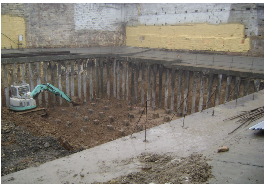
Рис. 2. Розробка котловану під палєво-плитний фундамент
