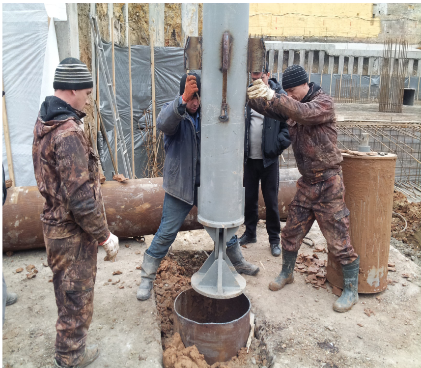
Рис. 4. Опускання штампа і колони труб у свердловину для визначення модуля деформації
