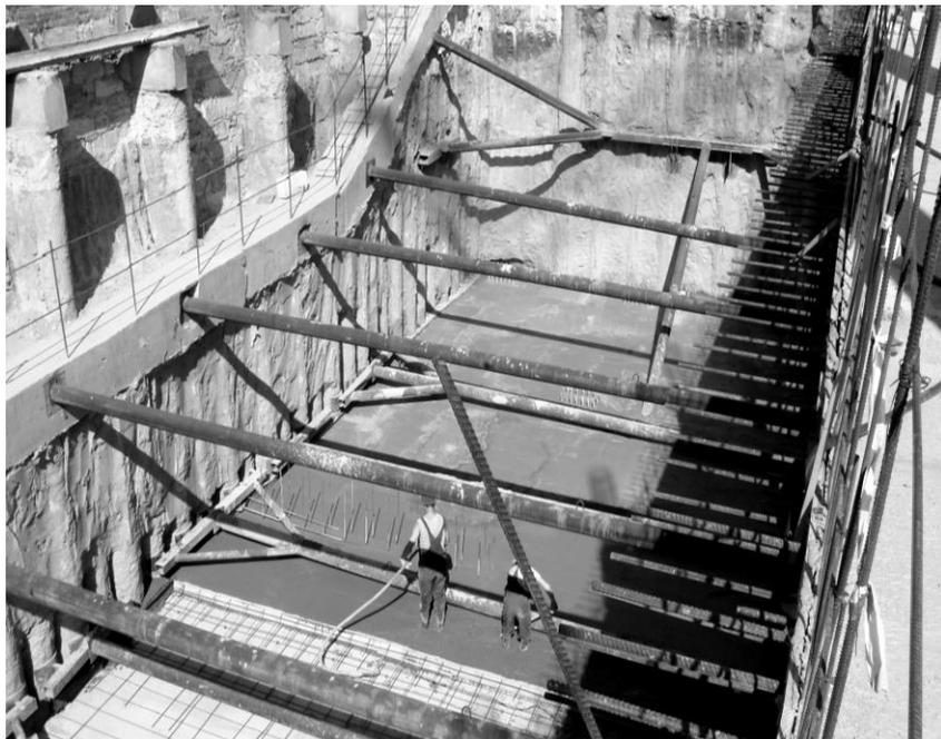
Рис.3. Устройство распорок при строительстве II -ой очереди
