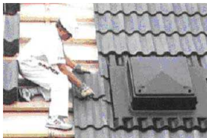
Рис. 3.40. Примыкание черепицы к вентиляционному люку
