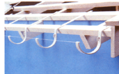
Рис. 4.4. Установка металлических кронштейнов
