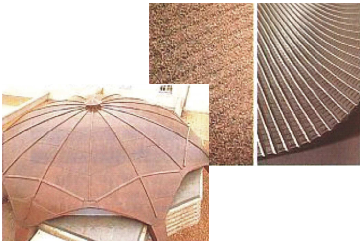
Рис. 2.9. Кровли из рулонных фольгированных материалов
