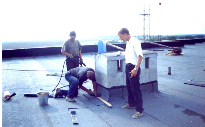
Рис. 7.8. Устройство примыканий к вертикальным поверхностям
