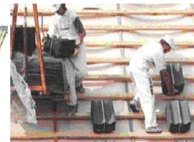
Рис. 3.35. Подъем черепицы на место установки
