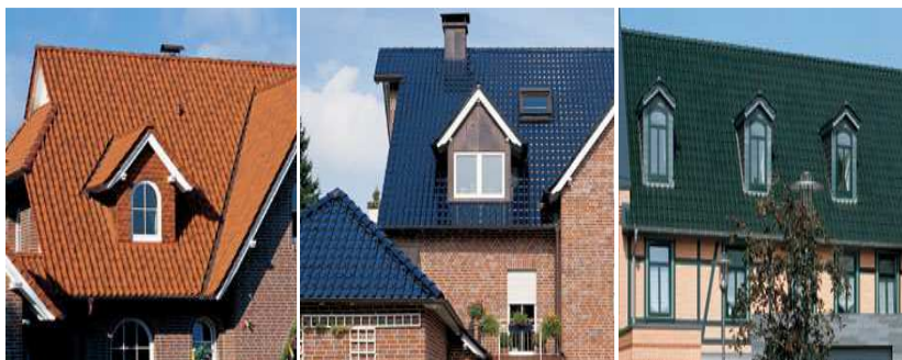
Рис. 3.33. Здания с черепичными кровлями
