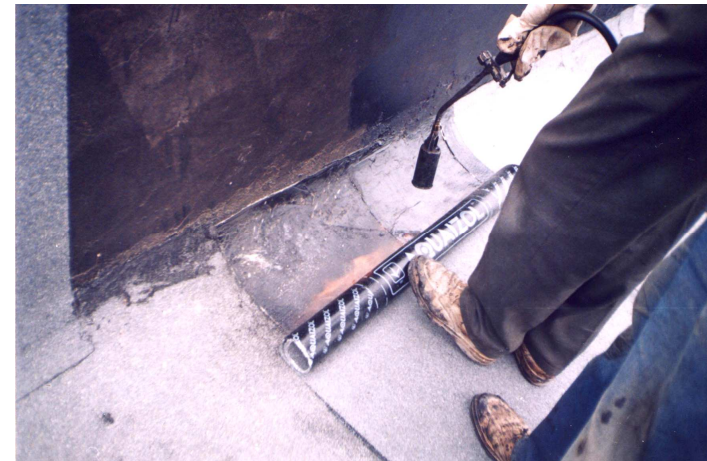
Рис. 7.9. Оплавление слоя битумной мастики газовой горелкой
