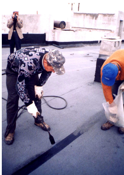
Рис. 7.7. Устройство кровельного ковра
