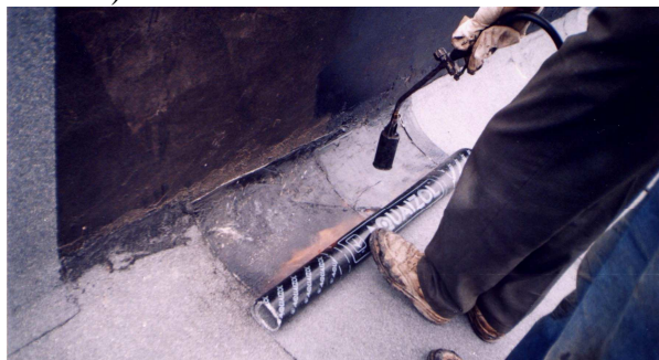
Рис. 2.11. Укладка рулонного материала наплавление
