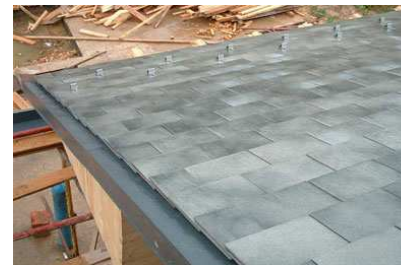
Рис. 3.48. Монтаж плиток формата 25x40 со стороны торцевой планки
