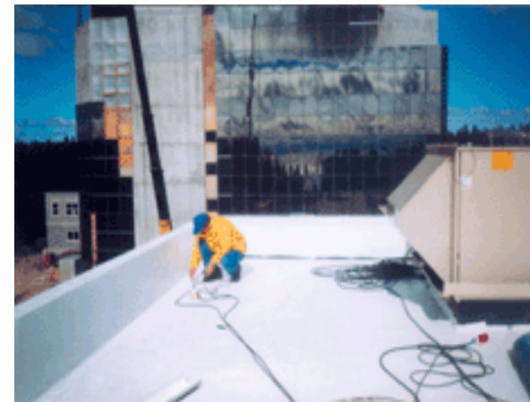
Рис. 2.19. Скрепление швов горячим воздухом
