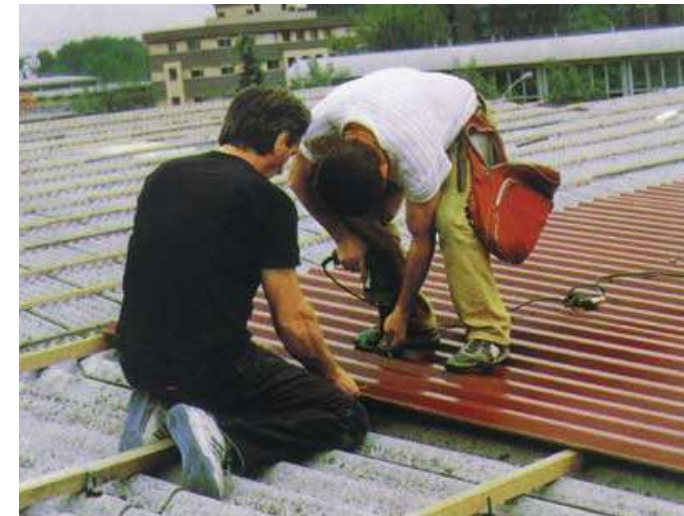
Рис. 3.8. Крепление профилированных листов к обрешетке
