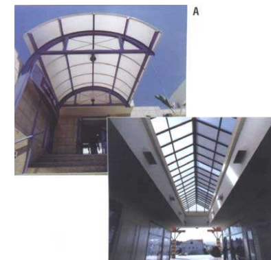
Рис. 3.110. Кровельные конструкции со светопропускающим заполнением из структурированных поликарбонатных панелей А-разъемное винтовое соединение; Б-неразъемное зажимное соединение.
