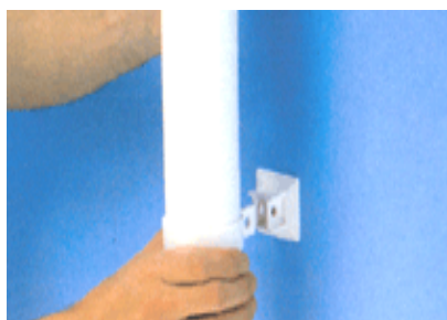
Рис. 4.20. Установка хомута для трубы
