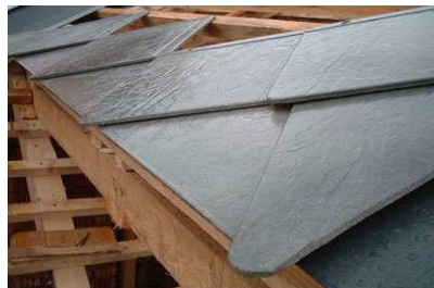
Рис. 3.47. Монтаж последующих рядов плиток формата 40x40.
