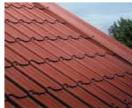
Рис. 3.26. Кровля из алюминиевой металлочерепицы (ALCAN)
