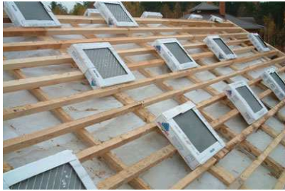
Рис. 3.45. Установка обрешетки с заданным шагом.
