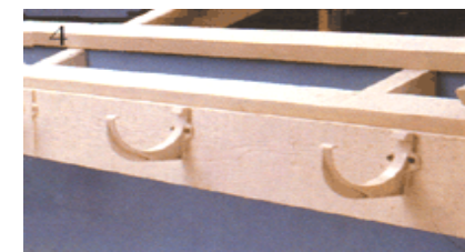
Рис. 4.5. Установка пластиковых кронштейнов
