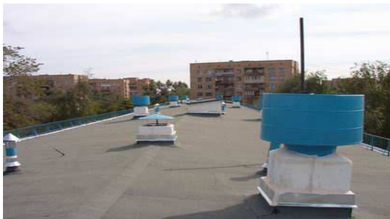
Рис. 2.8. Объект с кровлей из Филизола
