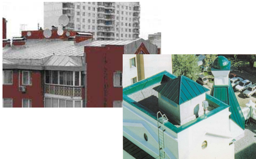
Рис. 3.6. Объекты с фальцевой кровлей
