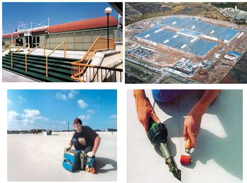
Рис. 2.20. Укладка мембран АЛЬКОРПЛАН при помощи специального сварочного оборудования и фена (слева на право).
