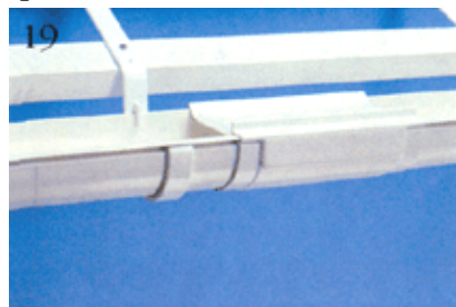
Рис. 4.18. Установка расширительного элемента
