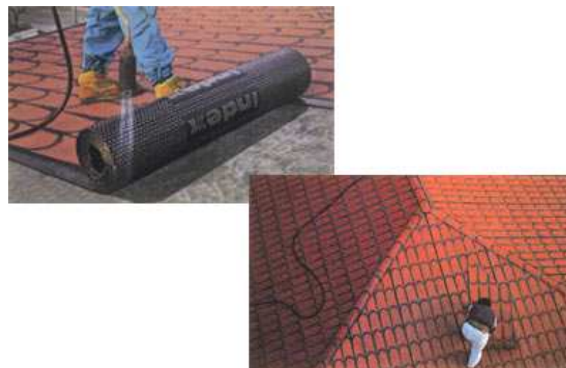
Рис. 2.5. Укладка рулонного материала INDEX, имитирующего натуральную черепицу.
