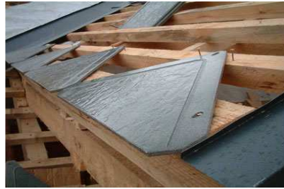
Рис. 3.46. Монтаж первого ряда плиток формата 40x40.
