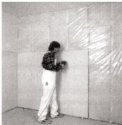
Рис. 7. Пример монтажа внутреннего утепления стен с устройством пароизоляции
