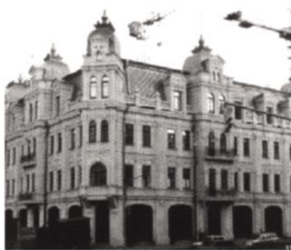
Рис. 9. Здание в историческом центре Киева после реконструкции и утепления по системе “Мокрый фасад”
