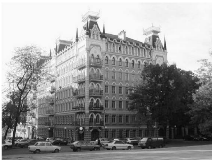
Рис. 5. Новое высотное жилое здание в существующей низкоэтажной застройке по ул. Маразлиевской в Одессе
