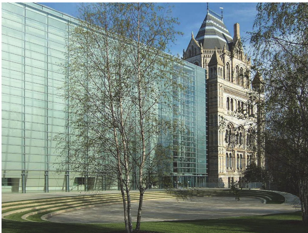
Рис. 2. Новый корпус музея – центр Дарвина. Фрагмент фасада.
