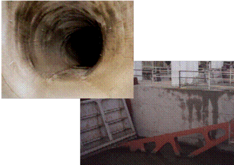
Рис.3. Применение модифицированного бетона при восстановлении гидротехнического тоннеля канала Днепр-Донбасс и конструкций главного шлюза дамб обвалования канала Дунай – Сасык
