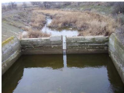
Фото 2. Водобійний колодязь водозливу
