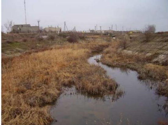
Фотод 3. Відвідний канал
