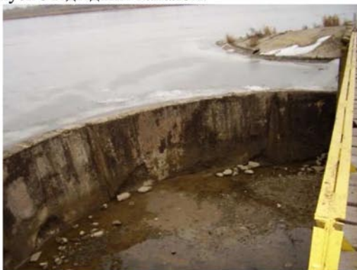
Фото 1. Переливний водозлив греблі
