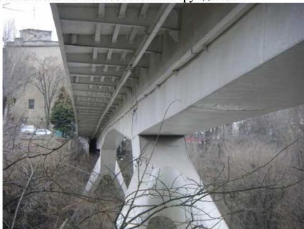
Рис. 2. Несущая система моста
