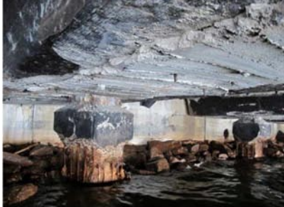
Рис.1.,2. Характер пошкоджень паль портових естакад
