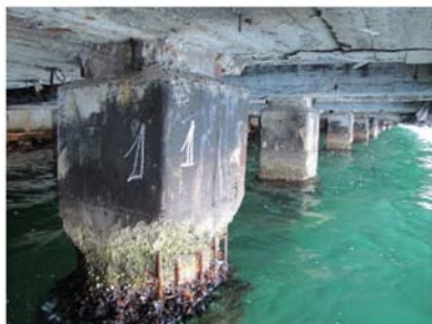
Рис.1.,2. Характер пошкоджень паль портових естакад
