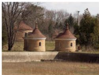
Рис.6. Камеры управления здвижками фильтров
