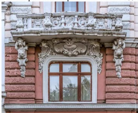
Окно правостороннего ризалита со стороны Дерibasовской
