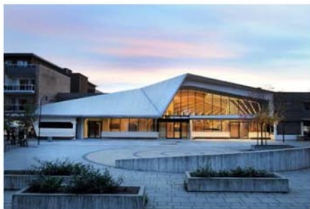
Рис. 4 Библиотека в городе Веннесла. Главный фасад
