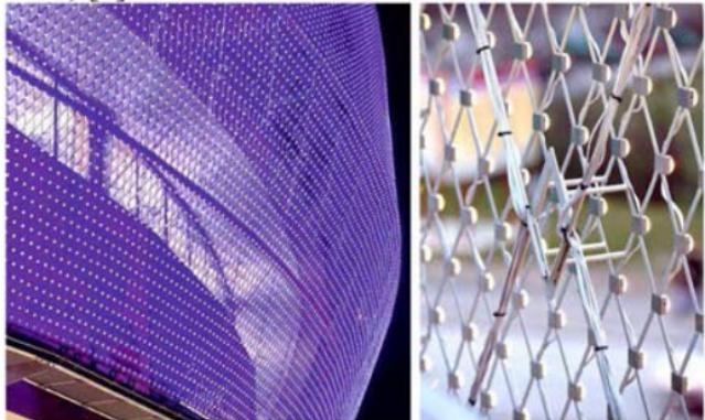
Рис. 3.1 Использование светодиодных медиафасадов. Stadion center, Австрия
