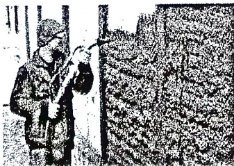
Рис. 2. Облицювання з шару торкрет-розчину
