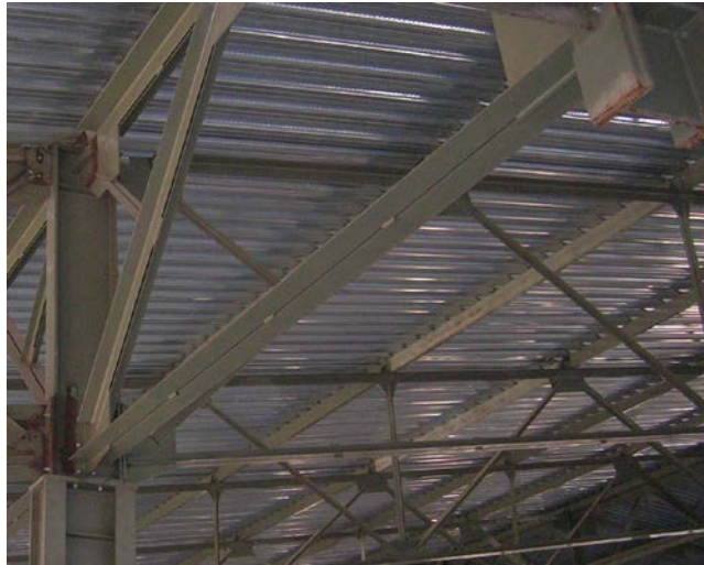
Рис. 11.21. Об'єднуючі листові планки (прокладки) в нижньому поясі підкрівляної ферми
