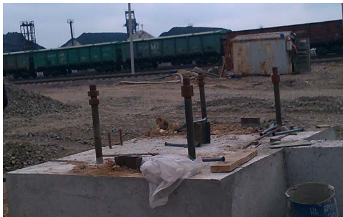
Рис. 10.6. Анкерні болти в монолітному залізобетонному фундаменті
