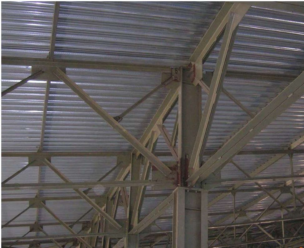
Рис. 11.19. Обпирання ферми на сталеву колону
