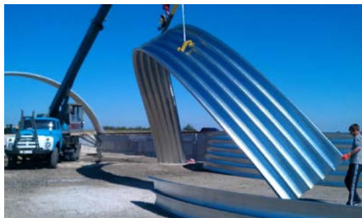
Рис. 12.7. Безкаркасне покриття арочного типу: а – загальний вигляд; б – монтаж зігнутого елемента арочного покриття
