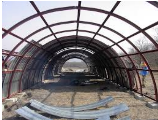
Рис. 12.6. Конструкція покриття з каркасом із арок
