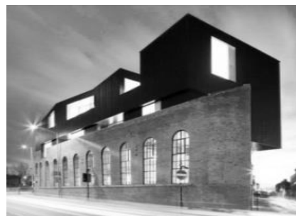
Рис.4. Надстройка над старым кирпичным складом в Шеффилде
