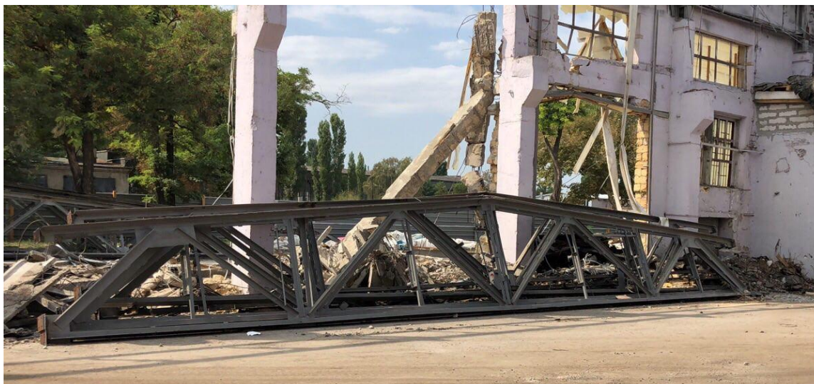
Рис. 1. Сталеві кроквяні ферми прольотом 18 м, що обстежуються
