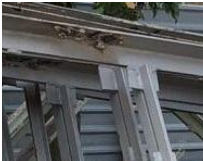
Рис. 2. Пропал отворів у верхньому поясі ферми
