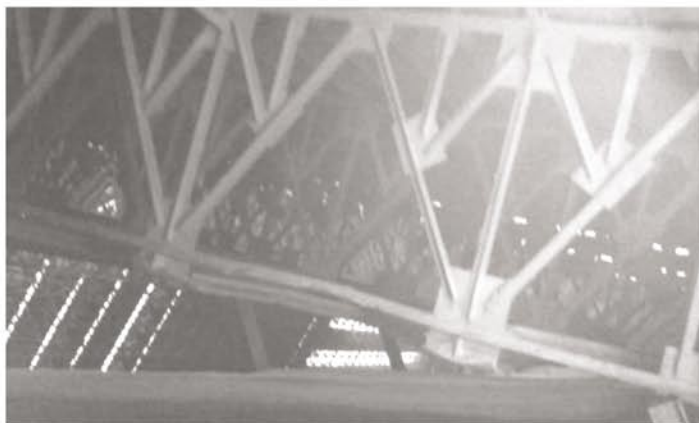
Мал. 1. Підсилена сталева кроквяна ферма за допомогою додаткової шпренгельної решітки
